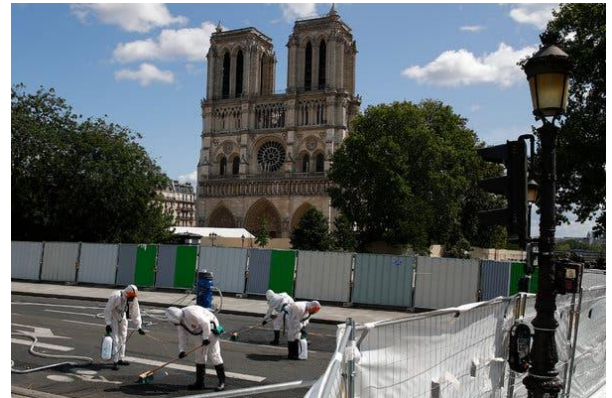
Figur 5 Oprydning efter blyforurening /8/
