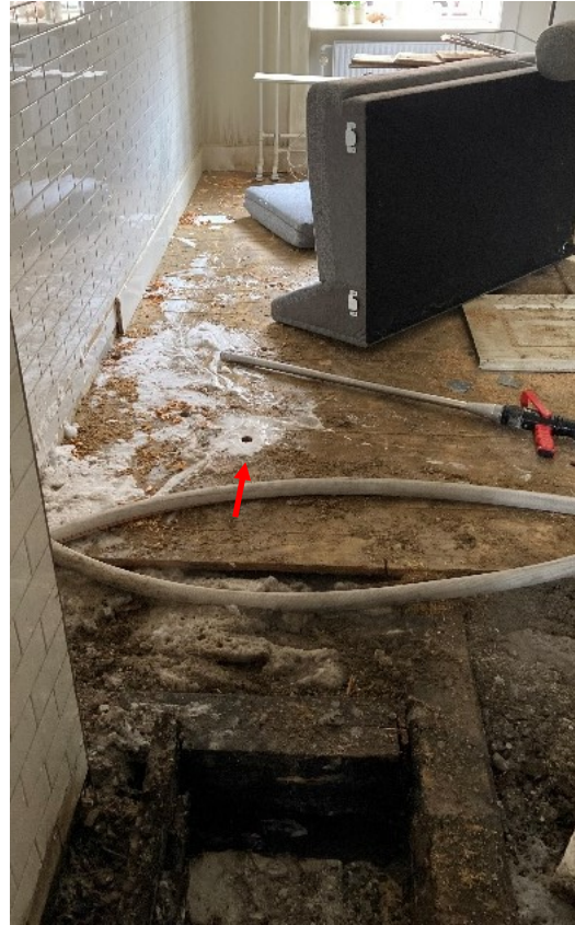
Figur 19 – Viser en brand i etageadskillelse. Den er slukket ved at bore huller, og påføre tør-CAFS. Derefter er gulvet skåret op for eftersyn/slukning.
