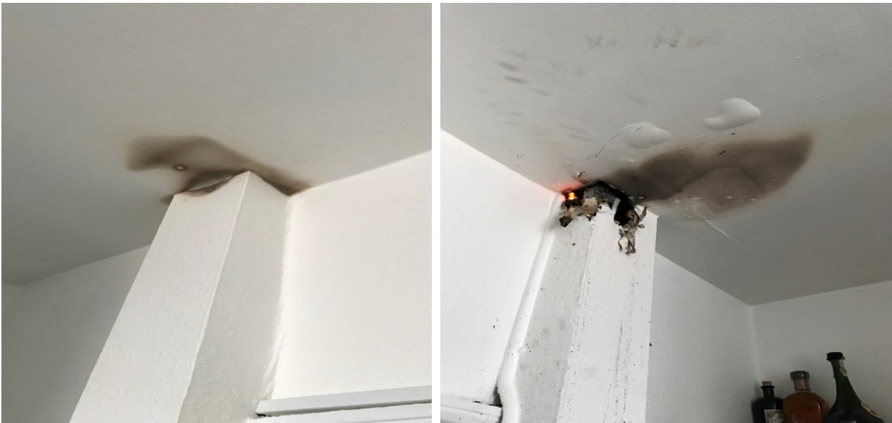
Figur 16 - Billedet viser brandspredning gennem etageadskillelse fra loft til øverste etage. Et eksempel på hvor I kunne anvende tør-CAFS op i etageadskillelsen for derved at påvirke brandforløbet og/eller virke som et forsinkende tiltag, inden brandspredningen
