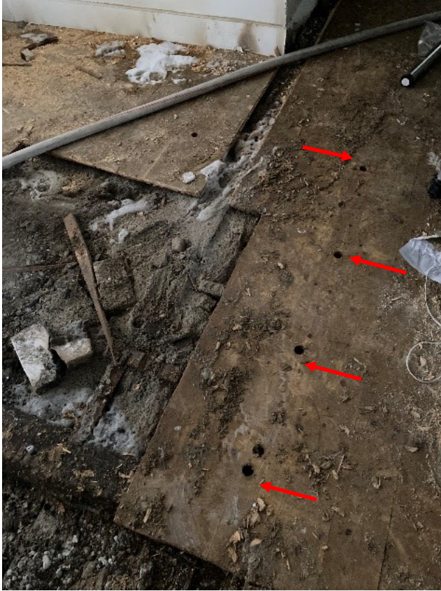
Figur 19 – Viser en brand i etageadskillelse. Den er slukket ved at bore huller, og påføre tør-CAFS. Derefter er gulvet skåret op for eftersyn/slukning.
