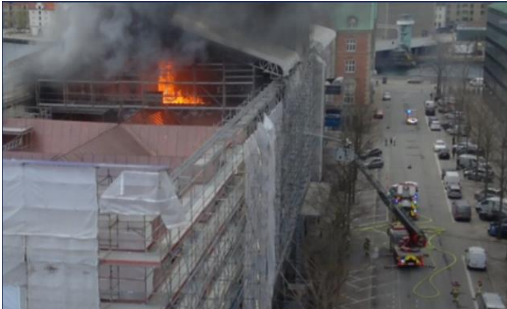
Figur 5. Översiktsbild av Börser. Byggarbetsplatsens södra sida utmed Slotsholmsgade klockan 07.42.
