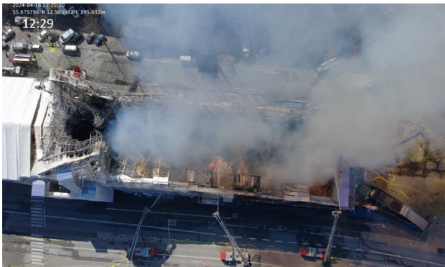
Figur 12. Klockan 12:29. Branden är begränsad till västra delen av byggnaden.
