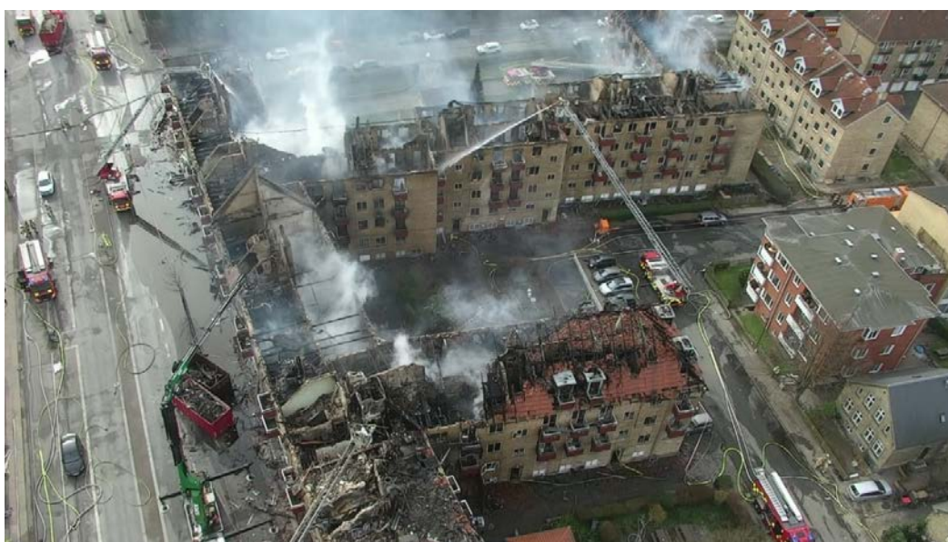
Figur 16: De skadede bygninger på Grøndals Parkvej
